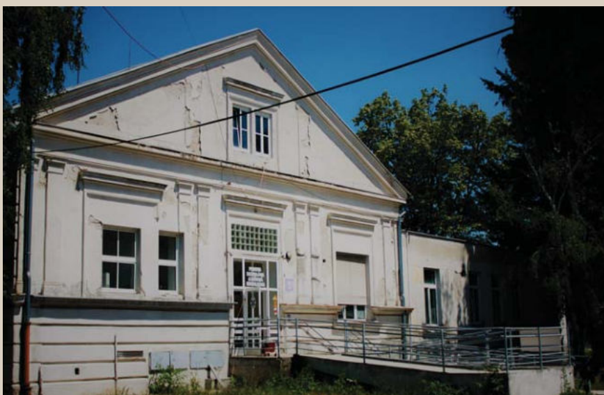
3.7 Bočný vstup do hlavnej budovy nemocnice s prístupovou rampou.
