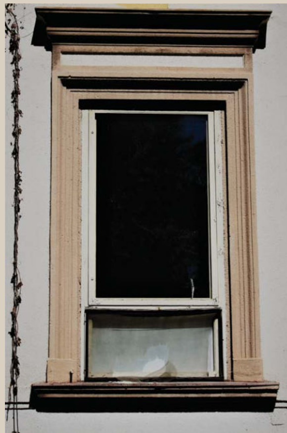
3.21 Detail okna fasády s plastickými šambránami a rímsou.
