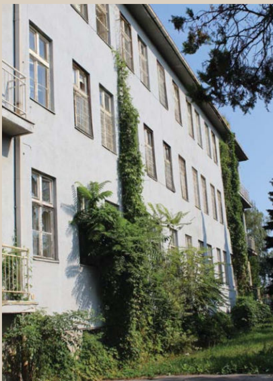
3.26 Zadná fasáda infekčného pavilónu.
