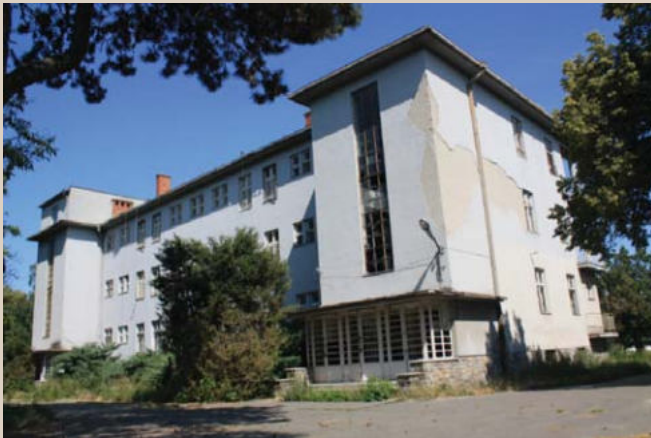
4.7 Exteriér objektu, hlavná fasáda (severozápad).
