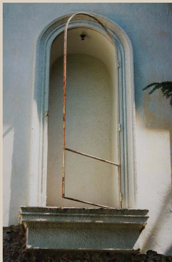
3.8 Detail niky na hlavnej fasáde hlavnej budovy nemocnice.
