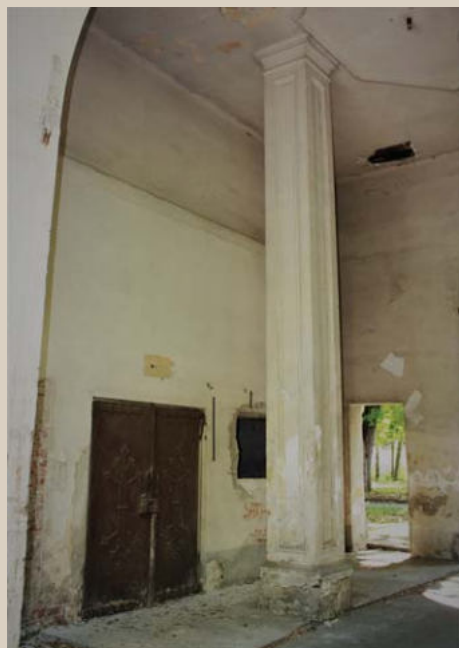
3.3 Prejazd kaplnkou do nádvorja a vstup do kaplnky dvojkrídlou bránou.
