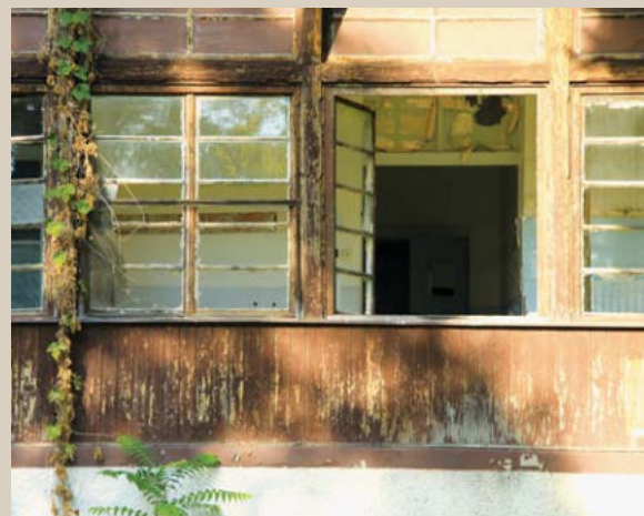
3.22 Detail zasklenej verandy kožného pavilónu s dreveným obložením.
