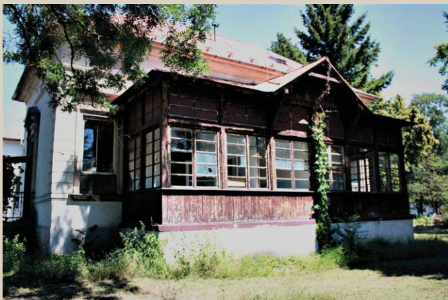
3.20 Drevená prístavba k bočnej fasáde kožného pavilónu na mieste pôvodnej terasy.
