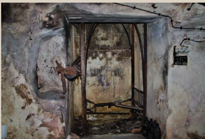
3.17 Technický výťah objektu v suteréne so zachovanými fragmentmi.
