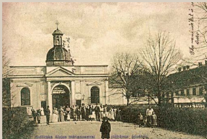
1.2 Nemocničná kaplnka a budovy na pohľadnici z roku 1913.
