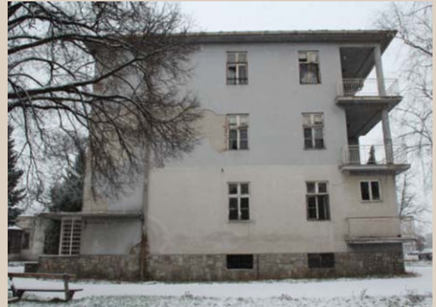
4.10 Exteriér objektu (juhozápad) na nároží s loggiami 2. polovice 20. storočia na vyvýšenom prízemí zamurované).
