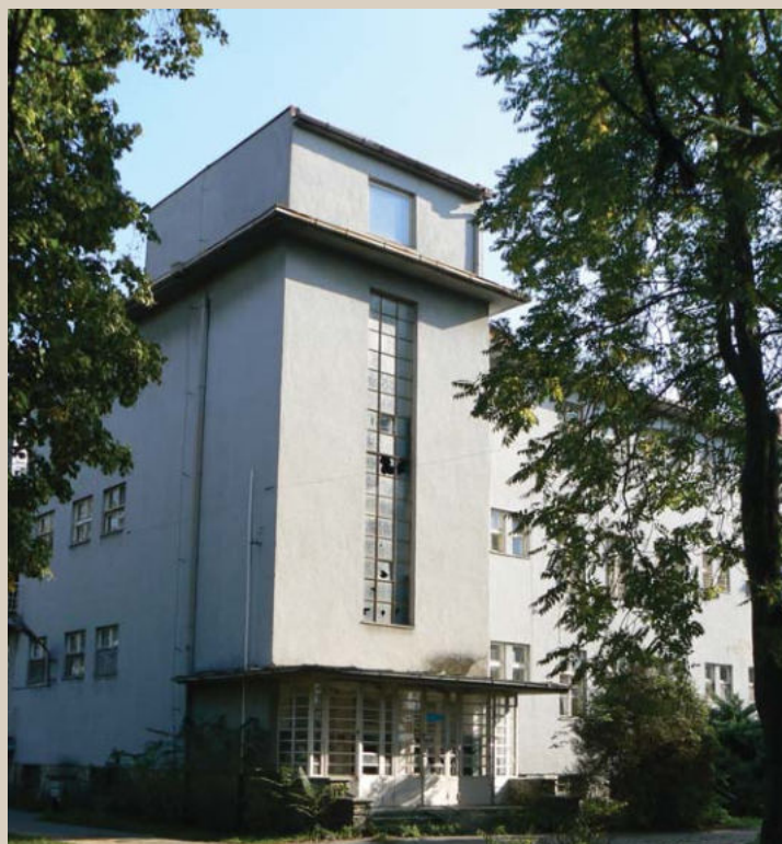
3.27 Hlavná fasádu infekčného pavilónu s nadstavbou strojovne výtahu.
