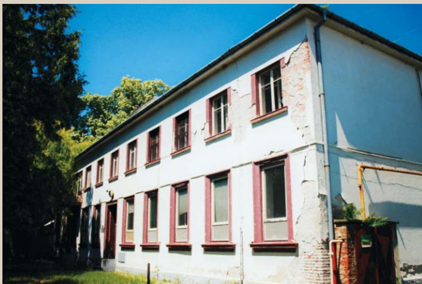
3.12 Pohľad na hlavnú fasádu administratívnej budovy orientovanú do nádvorja.
