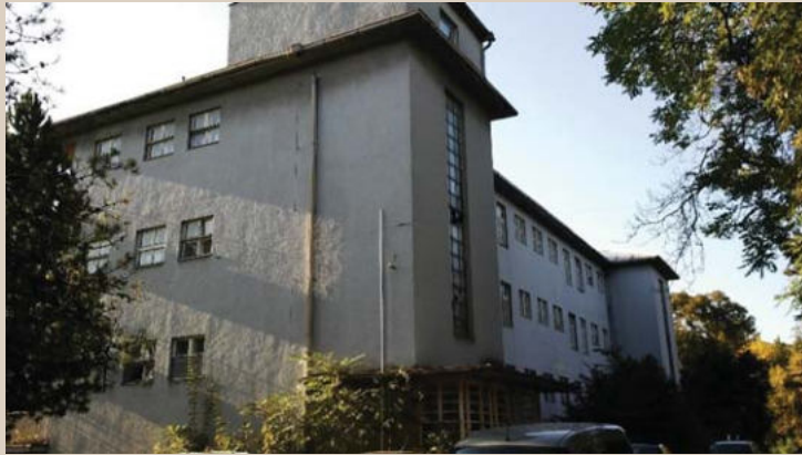
4.8 Exteriér objektu (severná strana) s nadstavbou výfahu.
